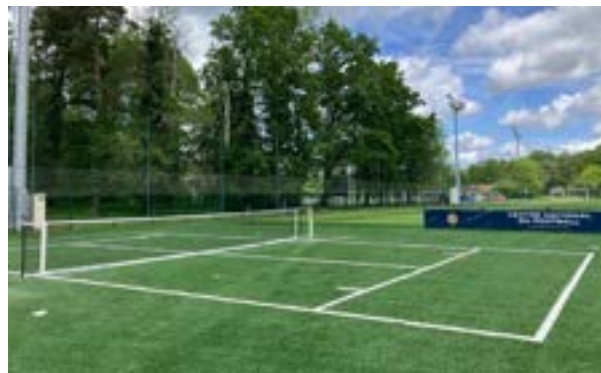
POSE PAR INCRUSTATION SUR UN TERRAIN EN GAZON SYNTHÉTIQUE EXISTANT Clairefontaine (Yvelines)
