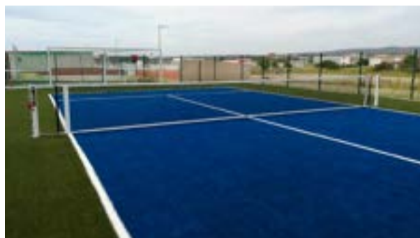
POSE D'UN GAZON SYNTHÉTIQUE SUR COUCHE DE SOUPLESSE Gigean (Hérault)
